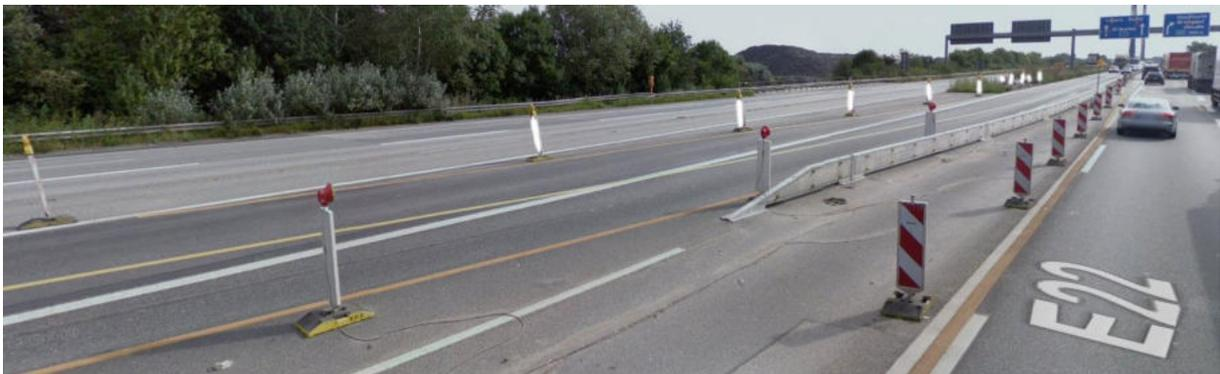
So würden die Leitbaken regelkonform aussehen, denn die weiße/nicht schraffierte Seite signalisiert den Autofahrern, dass diese Seite für die Leitung des Verkehrs nicht relevant ist, da ausschließlich nach rechts geleitet werden soll. Autofahrer behalten so einen besseren Überblick an Baustellen. Quelle: Google Maps (E22 Hamburg).
