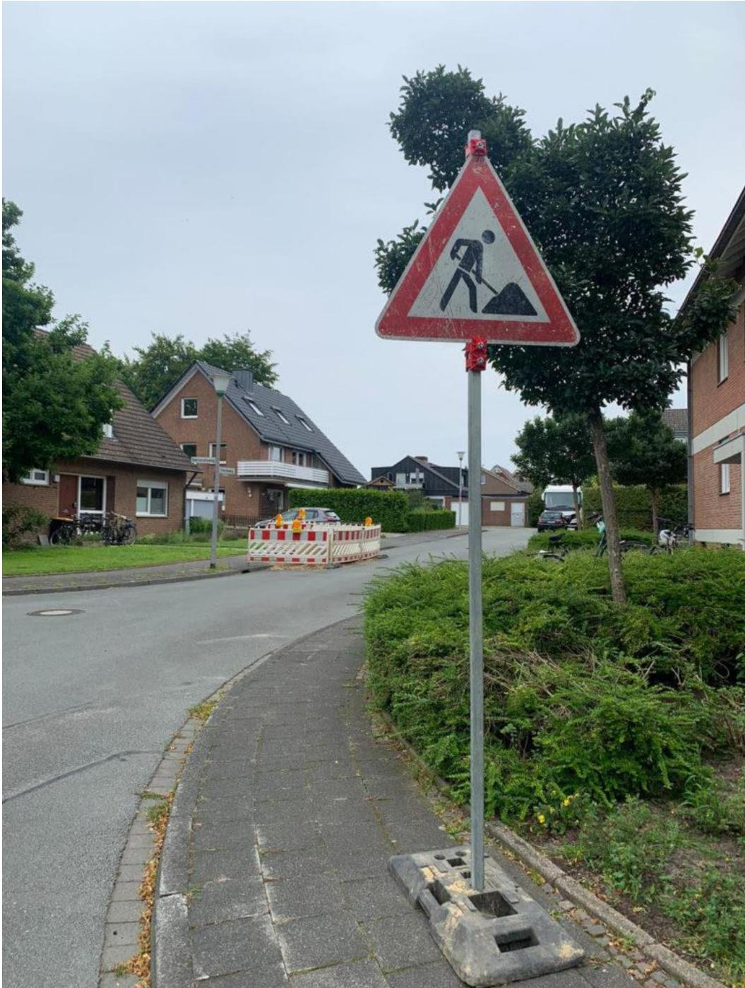
Hier ist zwar die Aufstellung rechts mit dem Mindestabstand berücksichtigt worden, jedoch ist das Verkehrszeichen nicht mehr deutlich erkennbar; die Farben sind bereits verblasst, das Schild zerkratzt und im oberen Teil abgeknickt. Auch die Sicherheitsklasse (in dem Fall K1) ist falsch berücksichtigt worden. Das VZ hat eine Seitenlänge von 900, so würde schon die Sicherheitsklasse von K2 greifen. Somit bietet diese Aufstellung keine optimale Darstellung.
